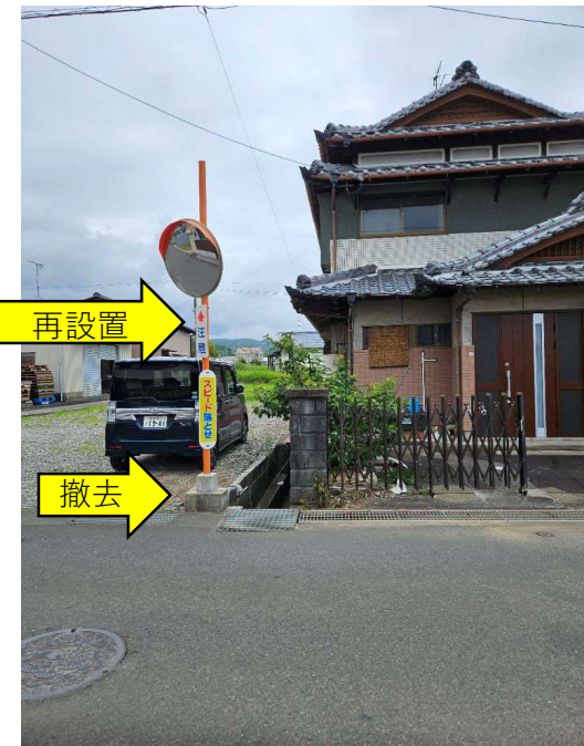
⑨足元基礎を撤去し、建替（Φ800）
