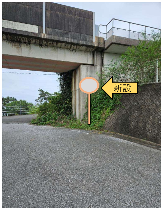
⑩カーブミラー1面新設（Φ800）、注意板取付
