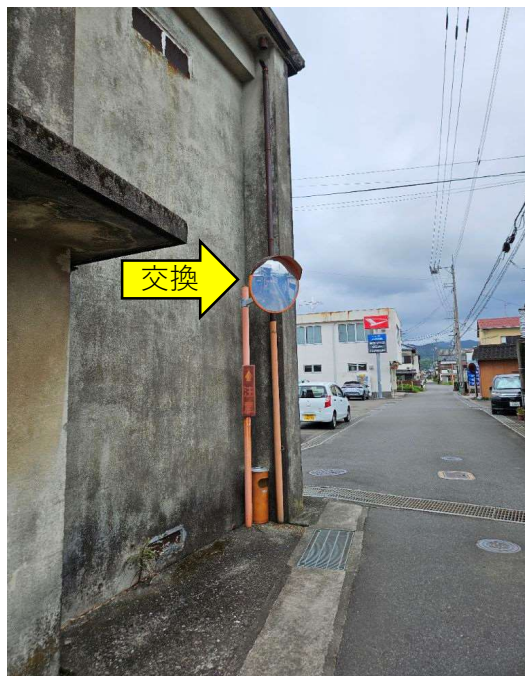
⑧カーブミラー1面交換（Φ600）、注意板交換
