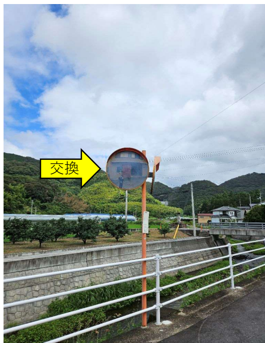
④カーブミラー2面交換（Φ800）、注意板交換
