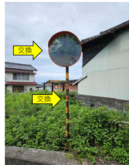
③カーブミラー1面・支柱交換（Φ800）、注意板取付
