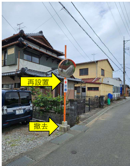
⑨足元基礎を撤去し、建替（Φ800）
