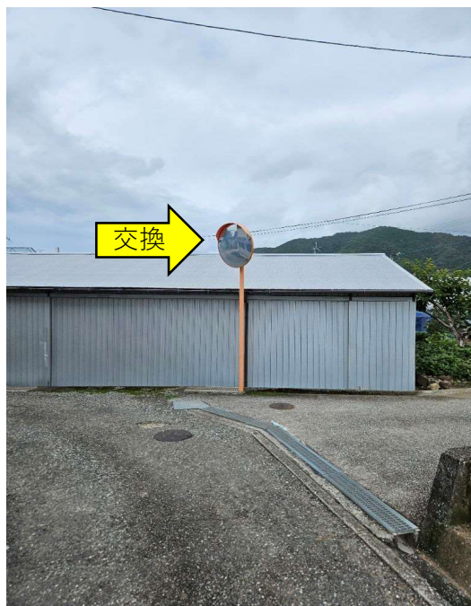
②カーブミラー1面（Φ800）交換、注意板取付
