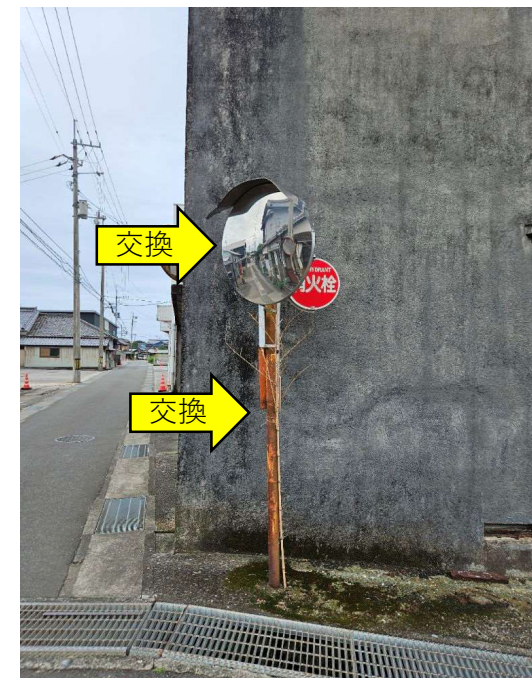
⑥カーブミラー1面・支柱交換（Φ800）、注意板交換
