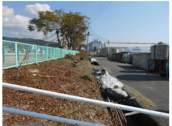
小学校南側道路と校庭との段差法面と水路
