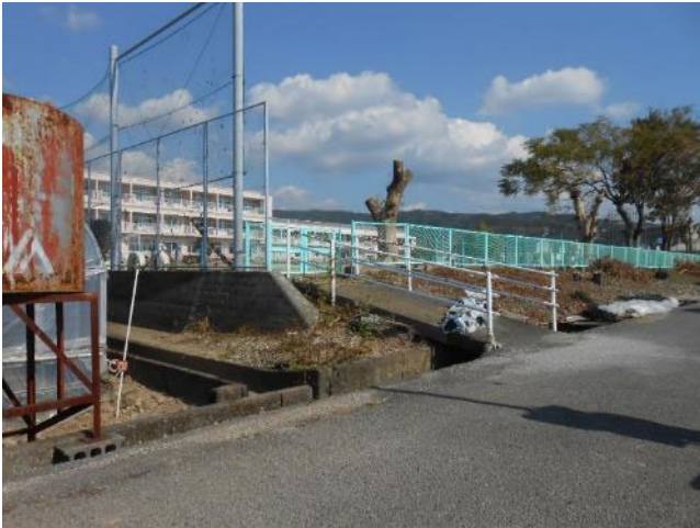
民地と小学校宅盤（校庭）との段差部分
