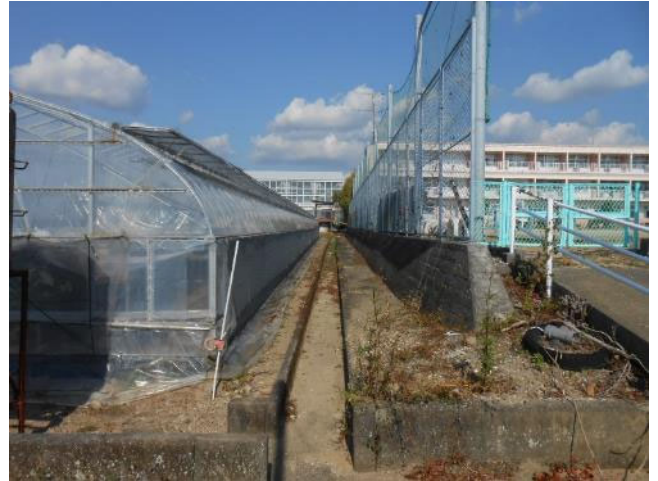
垂直擁壁の段差構造で、間に用排水路が走る
