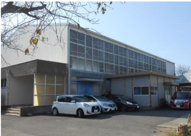
小学校体育館
