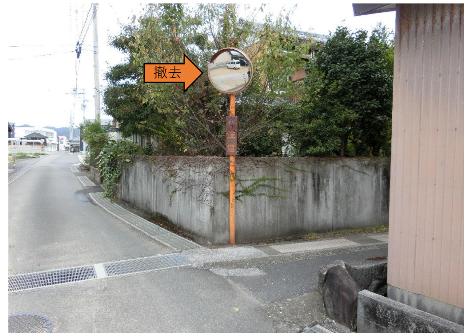
⑤カーブミラー・支柱撤去
