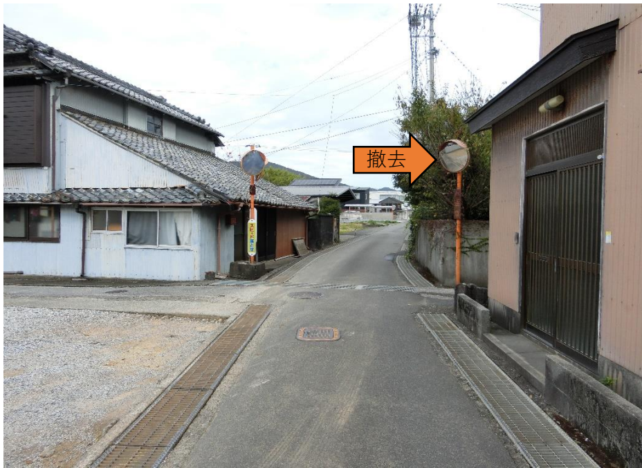
⑤カーブミラー・支柱撤去
