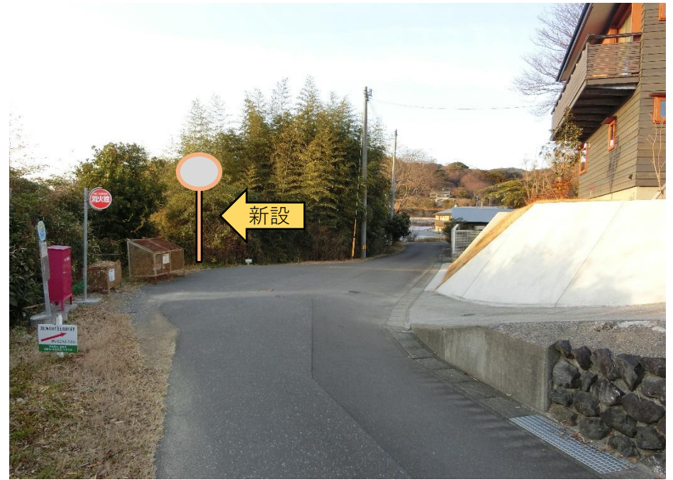
⑪カーブミラー1面新設（Φ800）、注意板取付
