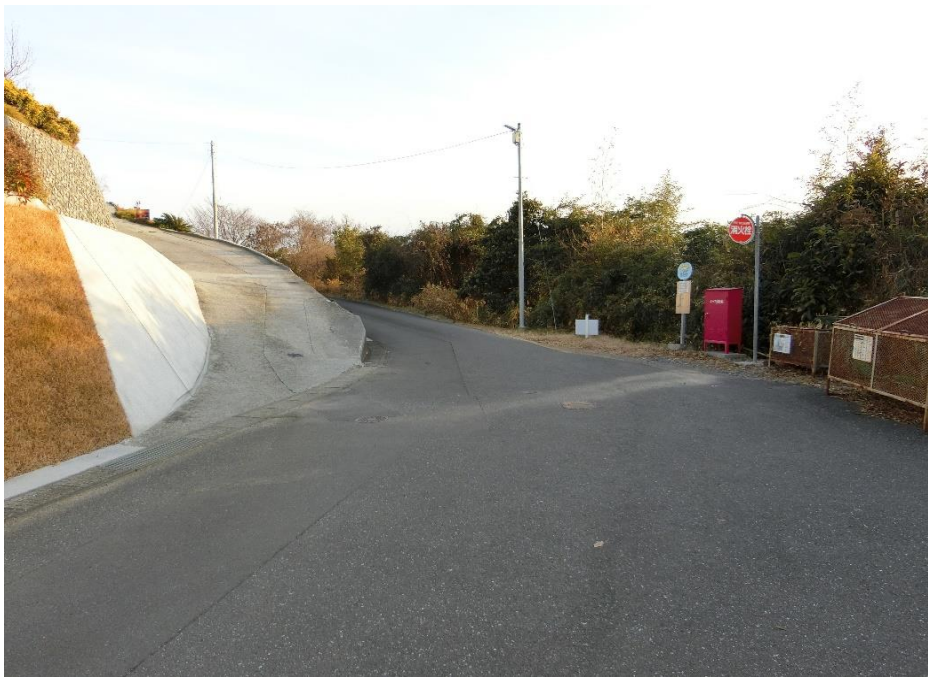
⑪カーブミラー1面新設（Φ800）、注意板取付
