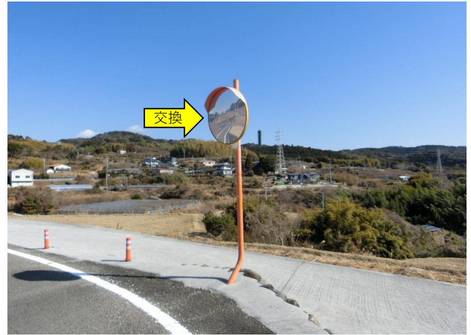
③カーブミラー1面交換（Φ800）、注意板取付
