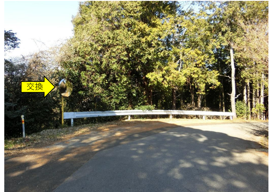
④カーブミラー1面・支柱交換（Φ800）、注意板取付
