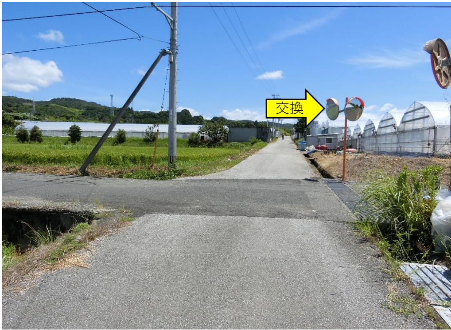
⑤カーブミラー1面交換（Φ800）、注意板取付
