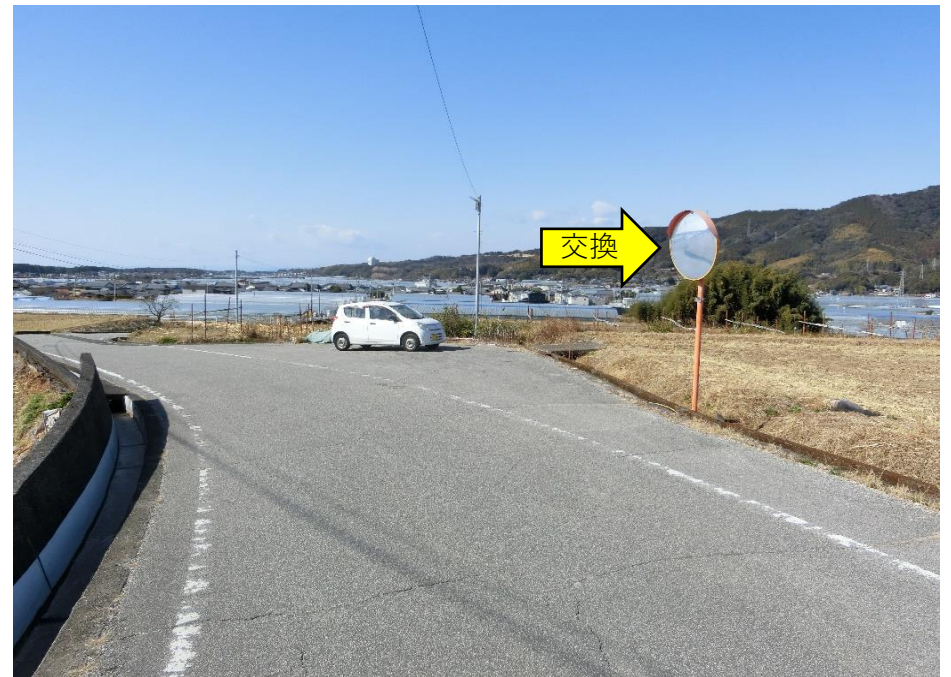
⑦カーブミラー1面交換（Φ800）、注意板取付
