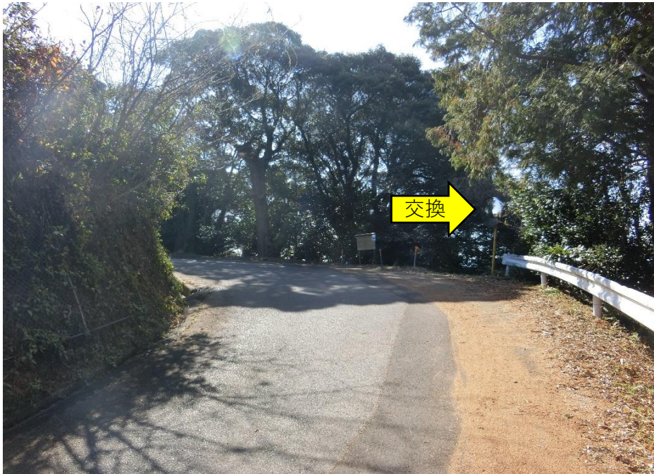
④カーブミラー1面・支柱交換（Φ800）、注意板取付
