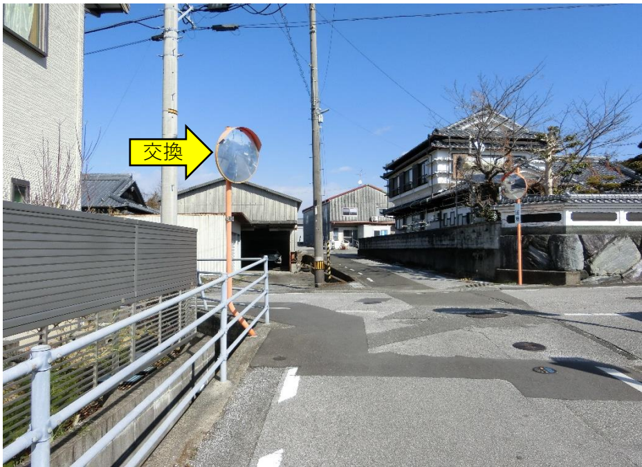
⑩カーブミラー1面交換（Φ800）、注意板取付
