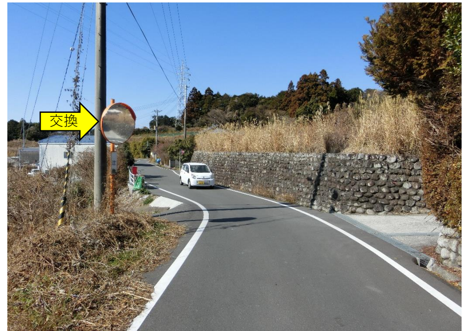
②カーブミラー1面（Φ800）交換、注意板交換
