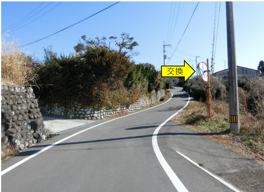
②カーブミラー1面（Φ800）交換、注意板交換
