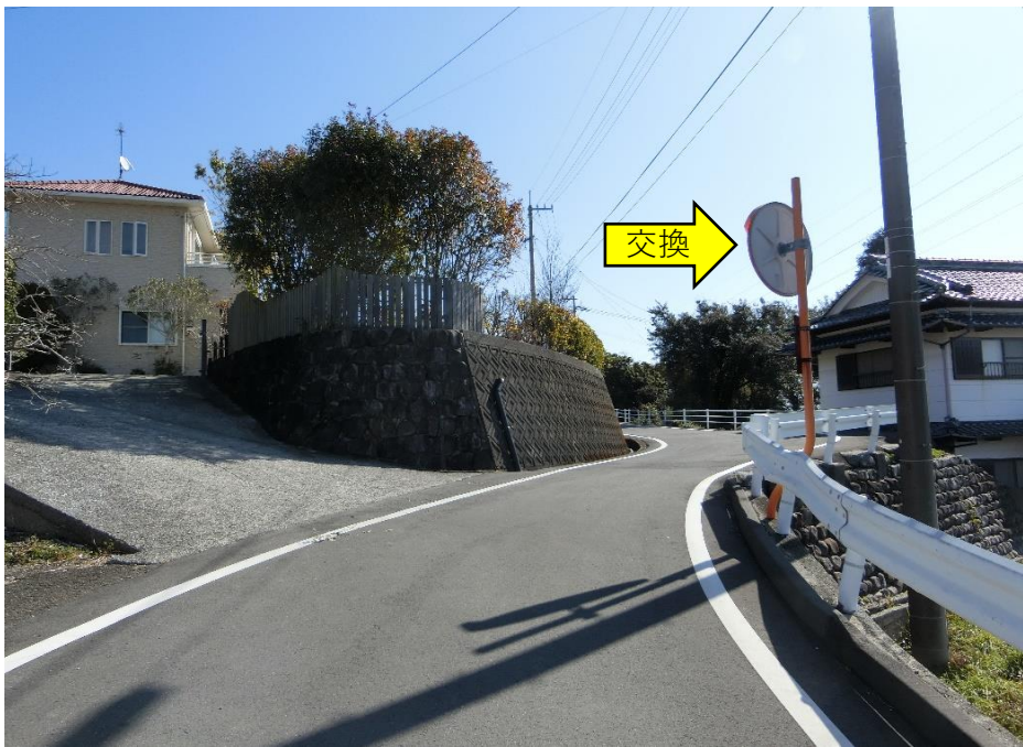
①カーブミラー1面交換（Φ800）、注意板交換
