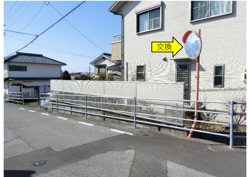
⑩カーブミラー1面交換（Φ800）、注意板取付
