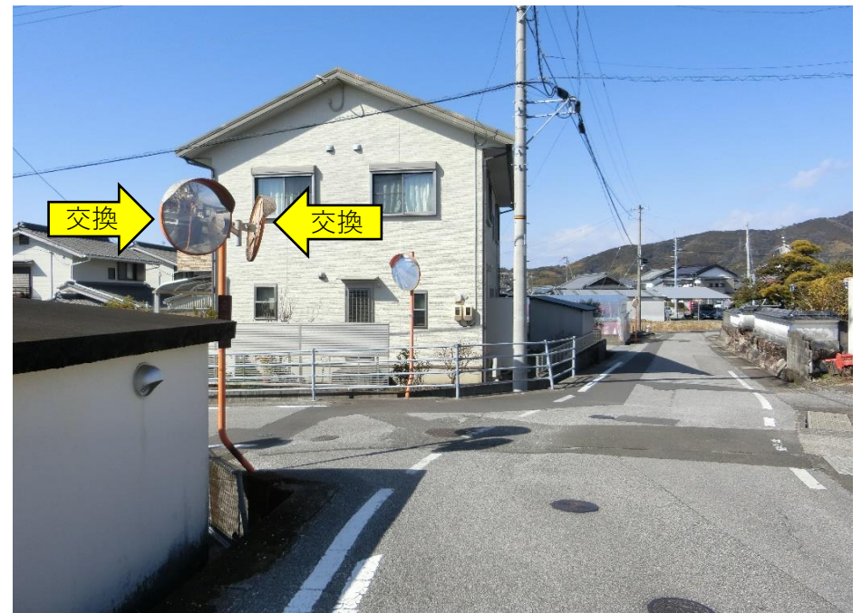
⑨カーブミラー2面交換（Φ800）、注意板交換
