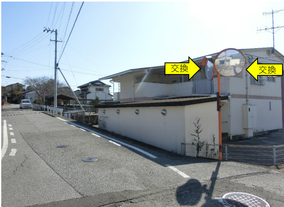
⑨カーブミラー2面交換（Φ800）、注意板交換
