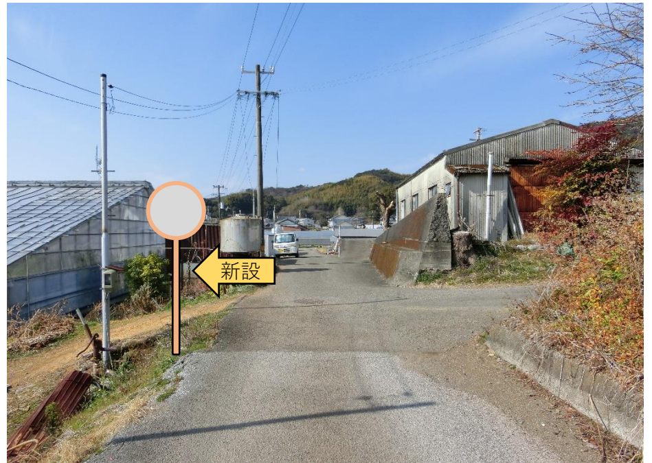
⑫カーブミラー2面新設（Φ800）、注意板取付
