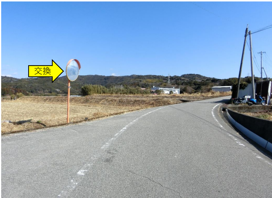
⑦カーブミラー1面交換（Φ800）、注意板取付
