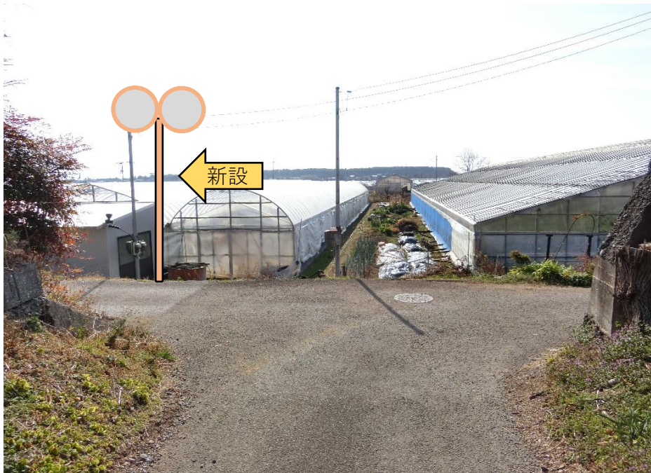
⑫カーブミラー2面新設（Φ800）、注意板取付
