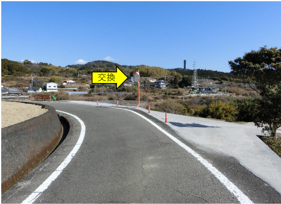
③カーブミラー1面交換（Φ800）、注意板取付
