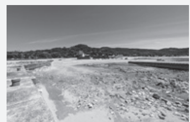
隆起し、陸地が露出した港
