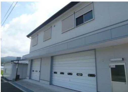
③外壁の落下、窓ガラスの割れはないか （和食防災拠点施設）
