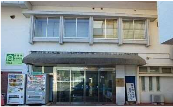
①外壁の落下、窓ガラスの割れはないか （芸西村村民会館）
