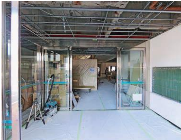
耐震化工事中の村民会館
