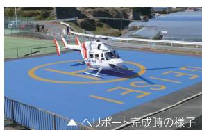
▲ヘリポート完成時の様子
