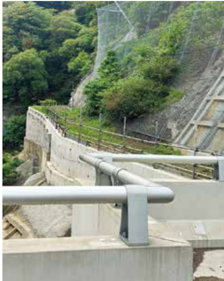
堤体上流の左岸
