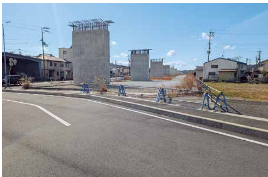
工事中の高架下
