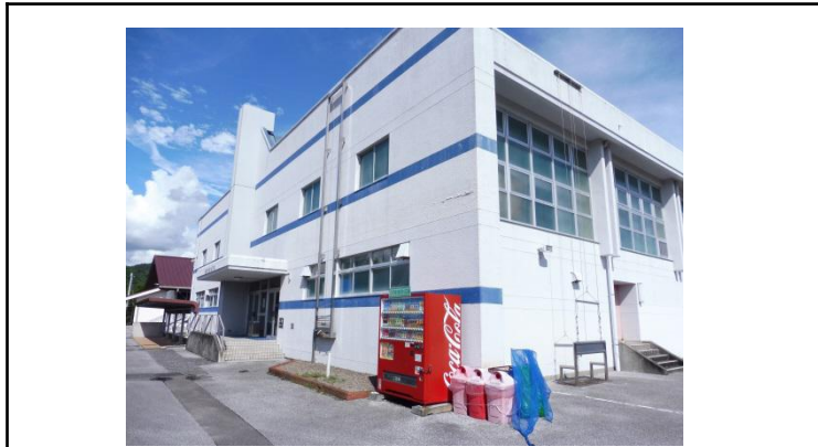
①外壁の落下、窓ガラスの割れはないか（村民体育館）
