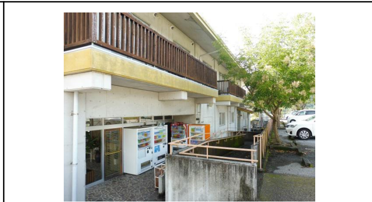
②外壁の落下、窓ガラスの割れはないか（村の家）
