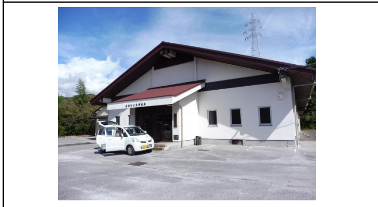
③外壁の落下、窓ガラスの割れはないか（柔剣道場）
