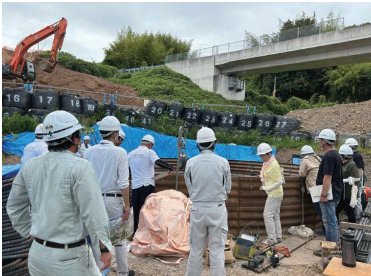
東部自動車道工事現場
