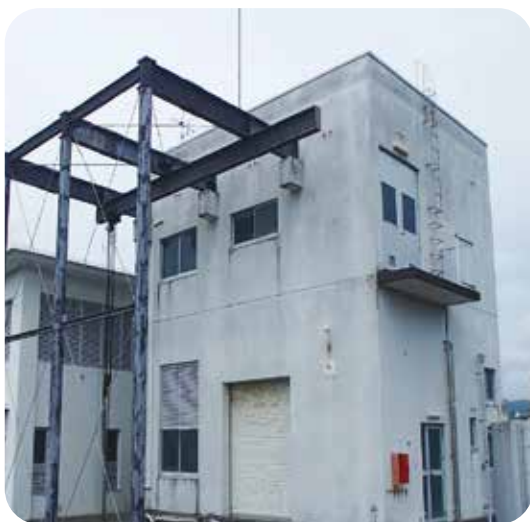
和食排水機場
