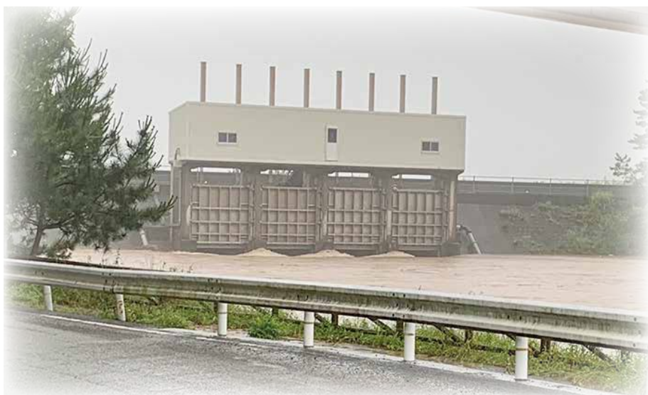
大雨時の和食川の導流堤
