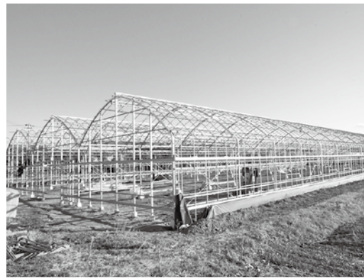
建設中のサポートハウス (ソノキ橋付近)
