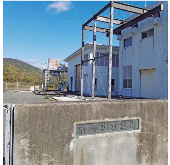
和食排水機場
